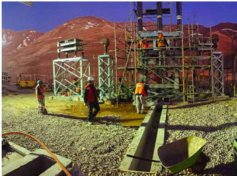
⤴ Montaje Filtros Cerámicos Inrush subestación eléctrica principal. Minera Lumina Cooper, Caserones. Copiapó.
