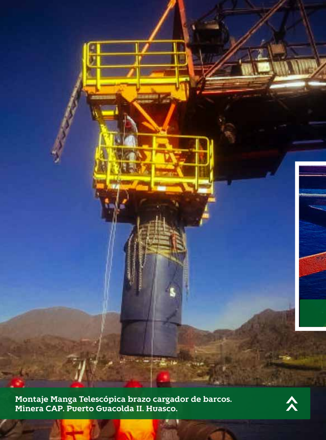
Extensión estructural del brazo de carga de Puerto Guayacán. CAP Minería. Coquimbo.
