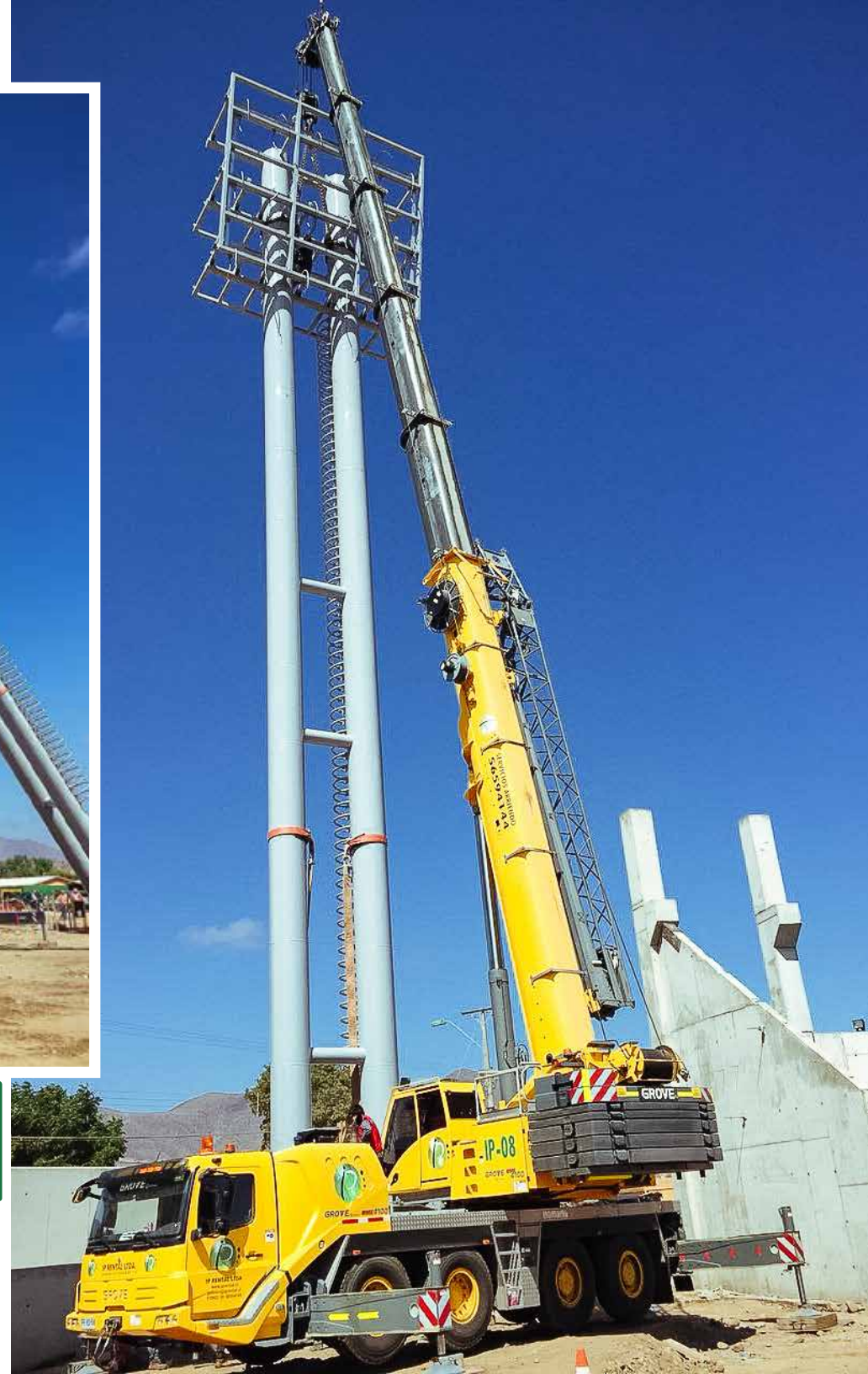
Montaje de Torres de Iluminación >> Estadio de Ovalle. Constructora Ikza. Ovalle.
