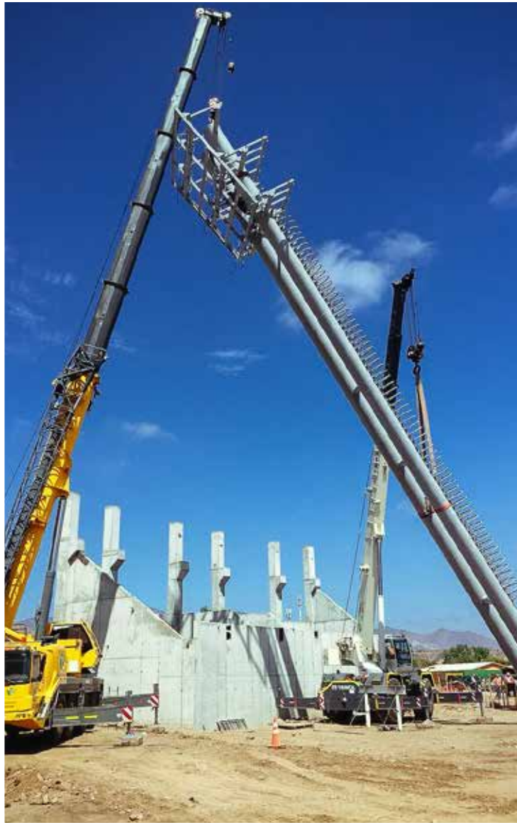
Montaje de Torres de Iluminación >> Estadio de Ovalle. Constructora Ikza. Ovalle.
