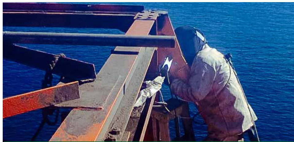
Extensión estructural del brazo de carga de Puerto Guayacán. CAP Minería. Coquimbo.
